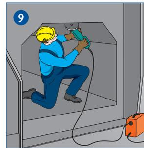
9 Bei Arbeiten unter erhöhter elektrischer Gefährdung besondere Schutzmaßnahmen beachten.
