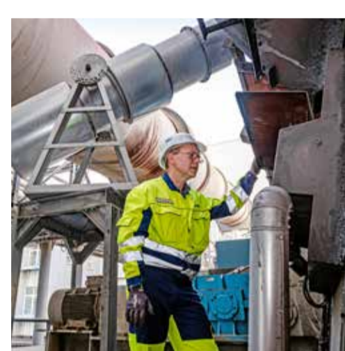
Im Drehrohren wird Rohmehl bei etwa 1.450 °C zu Klinker gebrannt. Dirk Erping überwacht die Anlage.
