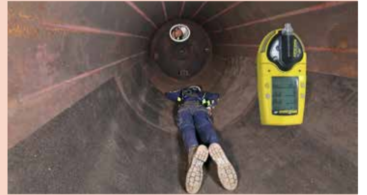
Bei der Rettungsübung stellt der Sicherungsposten fest, dass der Mitarbeiter im Zylinder Hilfe braucht. Sauerstoffmangel besteht nicht.
