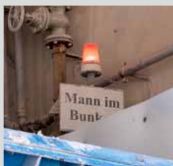
„Mann im Bunker“. Die Warn-einrichtung zeigt den Kollegen an, dass hier im engen Raum gearbeitet wird.
